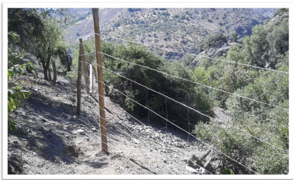
Figura N°8. Reparaciones de cerco. Tensado de malla.
